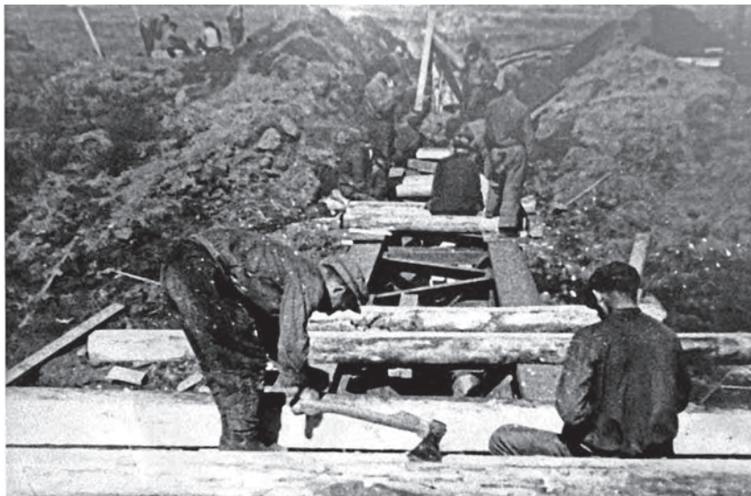
Строительство самой северной в мире железной дороги Дудинка – Норильск, 1937 г.
