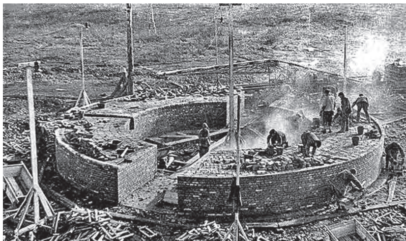
Сооружение заключёнными фундамента плавильной печи горно-металлургического комбината в Норильске, 1939 г.
