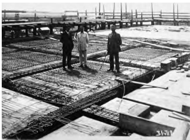
А. Д. Крячков (крайний справа) на крыше строящегося здания Сибкрайсоюза. 1925—1926 гг.
