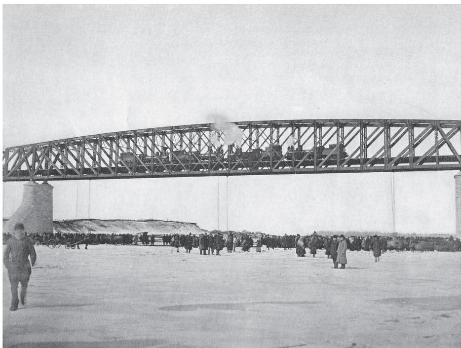
**Испытания консольного пролета моста через Обь.**
